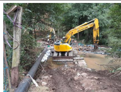
Pose de la nouvelle canalisation en période d'étiage
