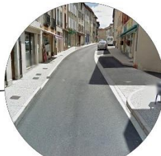
Marquage très important de la voie routière
