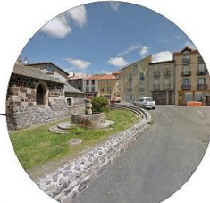
Espace à valoriser par un travail sur les limites
