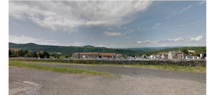
II Ouvrage en déblais (murs) :
